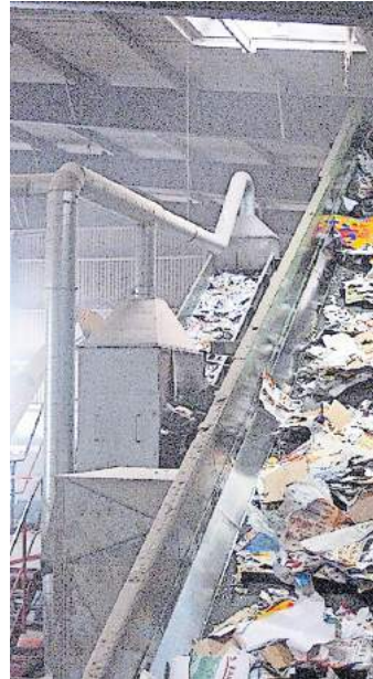
Transportbänder in der Papiersortieranlage.
