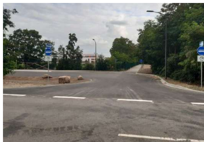
Zufahrt zur neuen Haltestelle am Schulzentrum Maxdorf
