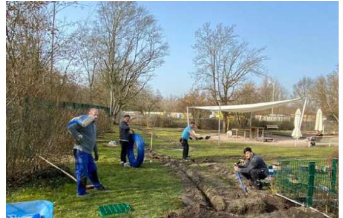
Die Mitarbeiter der Kreisbäder verlegen Bewässerungsleitungen im Außenbereich
