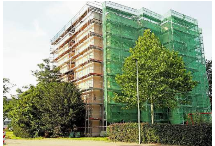
Fassaden- und Dachsanierung mit Austausch der Fenster am Objekt in Mutterstadt, Lilienstraße 73
