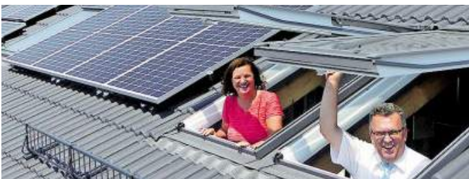
Bürgermeisterin Ilona Volk und Landrat Clemens Körner begutachten die Photovoltaikanlage am Objekt des Kreiswohnungsverbandes in Schifferstadt, Am Meisterschlag 2-4
