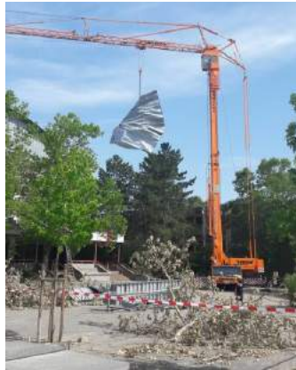
Teile des abgedeckten Daches wurden per Kran gesichert
