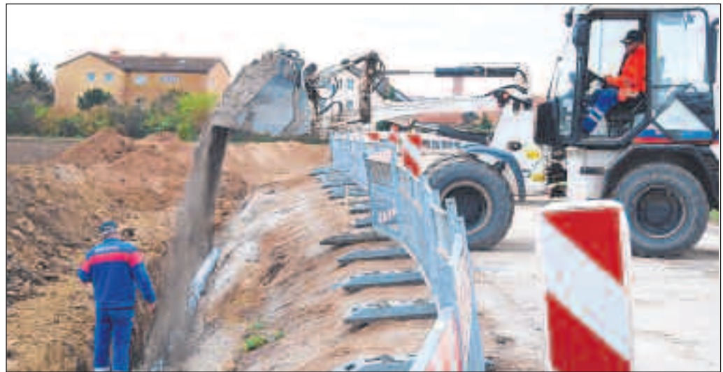
Maschinen- und Manneskraft: Am Ende der Schlichtstraße haben die Bauarbeiten für die Waldseer „Nordspange“ begonnen.
