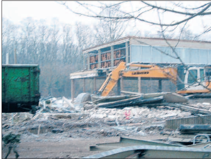
Bagger statt Badebecken: Das Kreisbad Maxdorf wird derzeit runderneuert.
