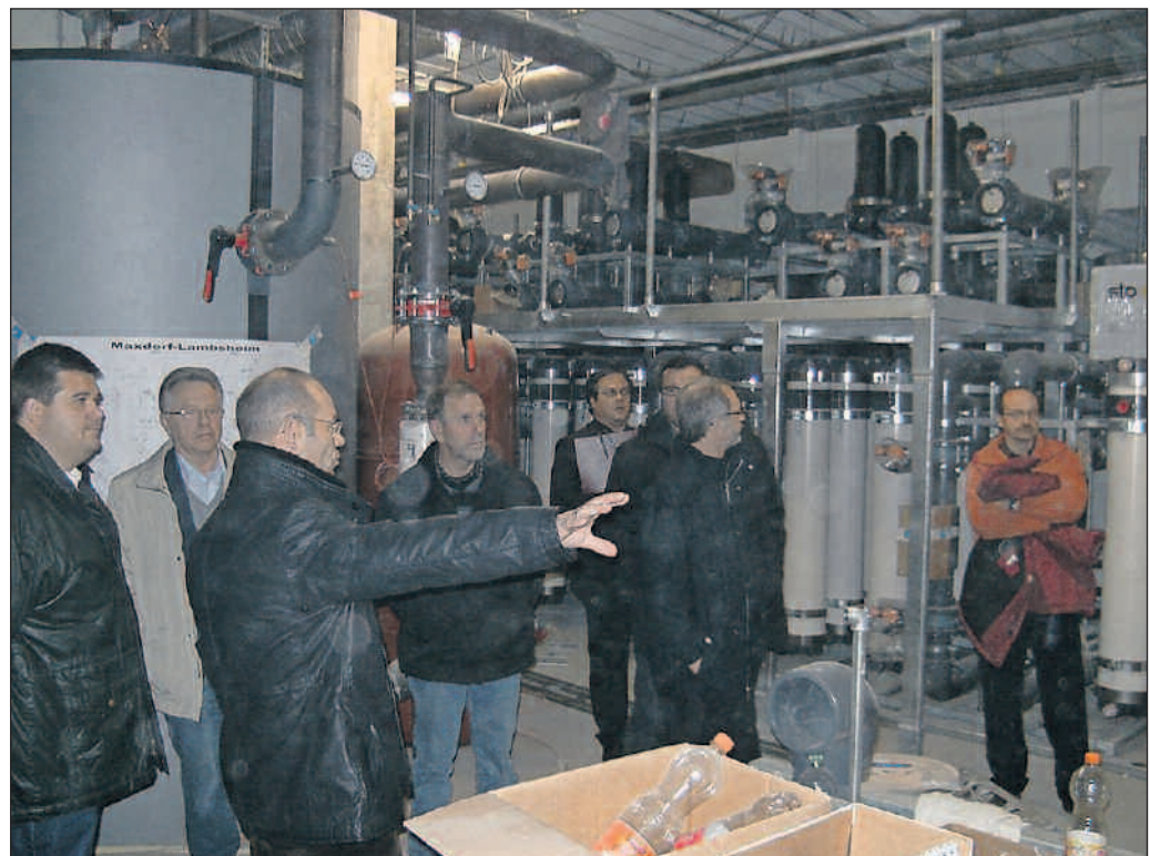
Frieren muss jetzt schon keiner mehr: Bauleiter Gero Höfer erläutert dem Bauausschuss des Kreises bei einem Ortstermin mit Dezernent Michael Elster die neue Gebäudetechnik im Kreisbad Maxdorf-Lambsheim. Kosten will man auf Dauer unter anderem dadurch sparen, dass zum Teil mit Abwärme aus dem nahe gelegenen Wasserwerk geheizt wird.
