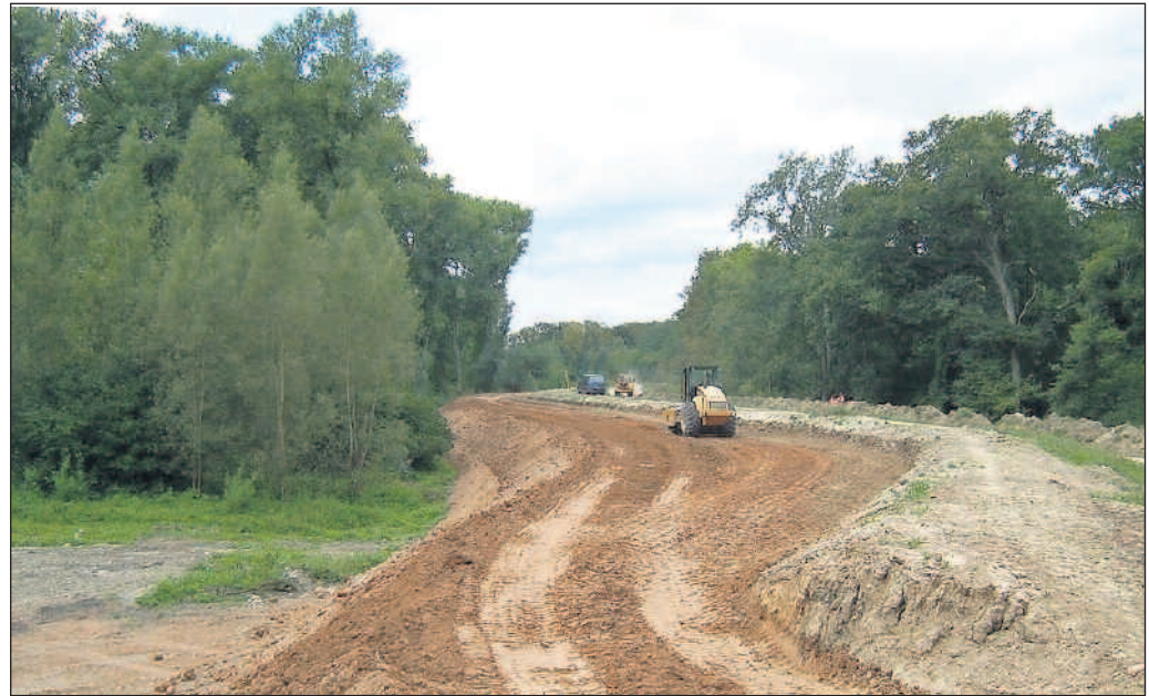
Inzwischen abgeschlossen: Die Erdarbeiten zur Erhöhung des Rheindeichs im Bereich der südlichen Kreisgrenze.
