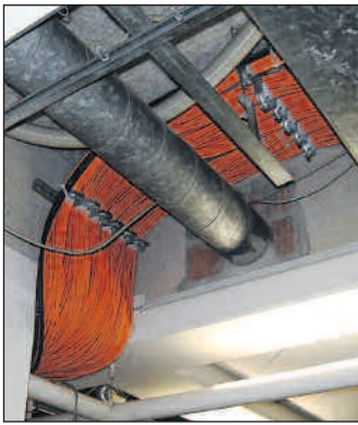
Kabel über Kabel: die neue 'Datenautobahn' der Kreisverwaltung
