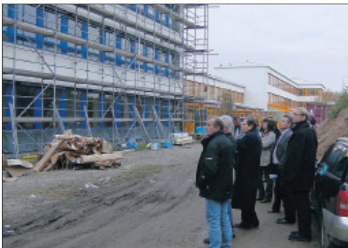
Der Bauausschuss begutachtet die Fassadensanierung im Schulzentrum Maxdorf
