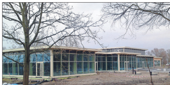
Bereitet dem Baudezernenten wenig Freude: die Bad-Baustelle an der Maxdorfer Gemarkungsgrenze zu Lamsheim
