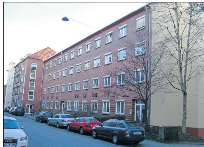
Dieses Gebäude in der Ludwigshafener Dörrhorststraße dient als Anlaufstelle
