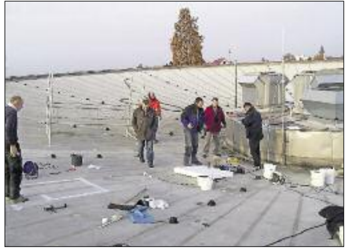
Statiker, Mitarbeiter der Kreisverwaltung und Techniker untersuchen die Dachfläche ausgiebig.
