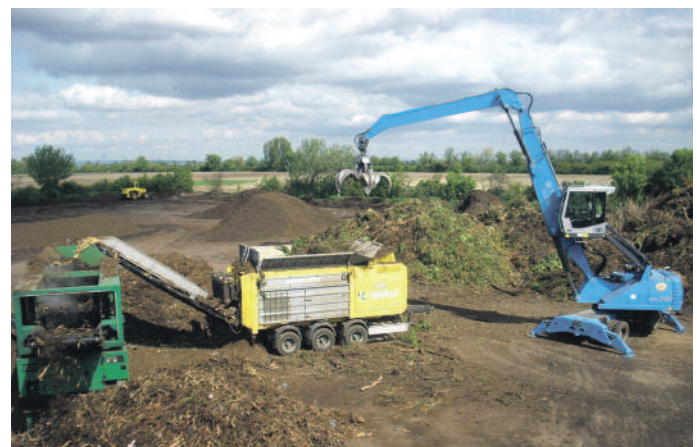
Abb.2: Hochwertige Grünabfallverarbeitung in der Biokompostierungsanlage Mutterstadt
