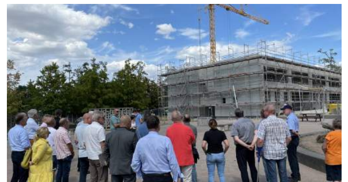
Kreis- und Bauausschuss überzeugten sich von den Bau-Fortschritten.
