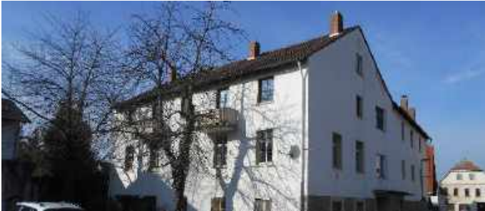
Wurde im Mai 2019 abgerissen: das alte Rathaus in Hochdorf-Assenheim
