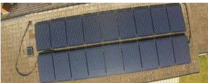
Neue Heizungsanlage auf dem Dach der Wohnanlage Am Damm 7-11 in Altrip.
