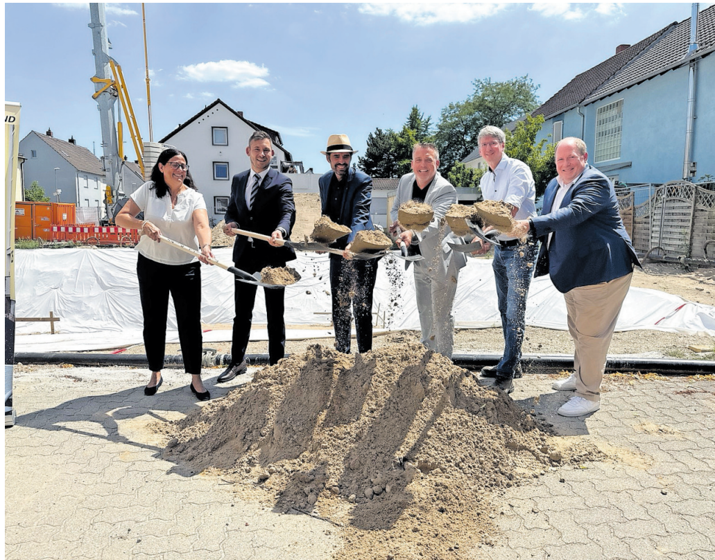
Packen tatkräftig beim Spatenstich mit an: Sandra Baumbach (Vorstandsmitglied der ISB-Förderbank), Christopher Kropp (Geschäftsführer KVV), Sven Teuber (Bauminister), Volker Knörr (Landrat und KVV-Vorstand), Christopher Diehl (Architekt) und Thorsten Leva (Bürgermeister Mutterstadt).
