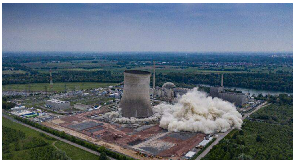
Sprengung der Kühltürme des KKW Philippsburg
