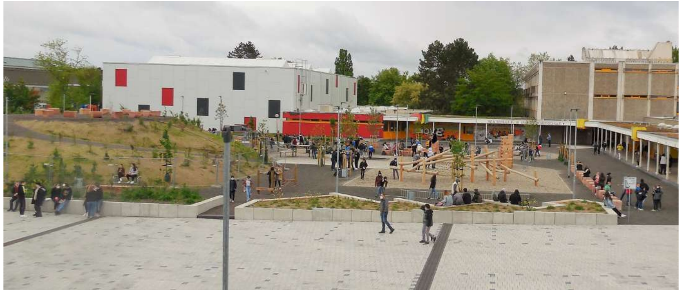
Blick auf den neuen Schulhof der Realschule plus Schifferstadt (im Hintergrund auch die energetisch sanierte Sporthalle)
