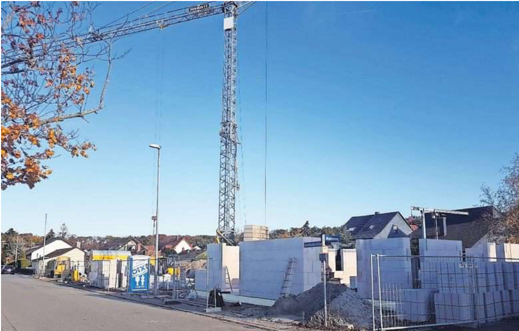
Mit dem Bau der 14 geförderten Wohneinheiten in Schifferstadt wurde bereits begonnen
