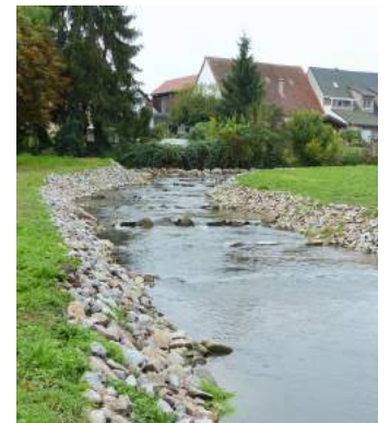
Gelungene Baumaßnahme: die idyllische Fischtreppe an der Wingertsmühle in Dudenhofen
