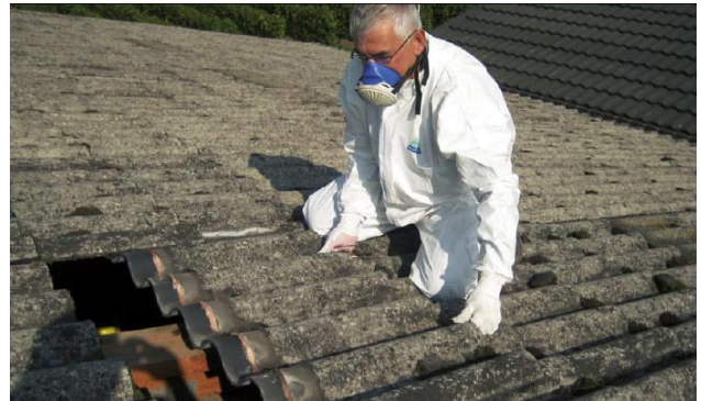
Abb. Rückbau eines Asbestzement-Daches
