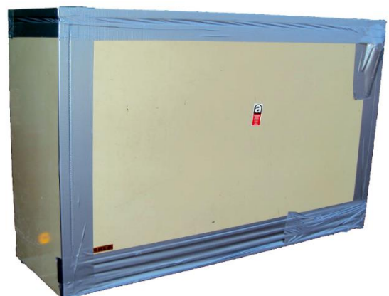
Beispielfoto: abgeklebtes Nachtspeichergerät
