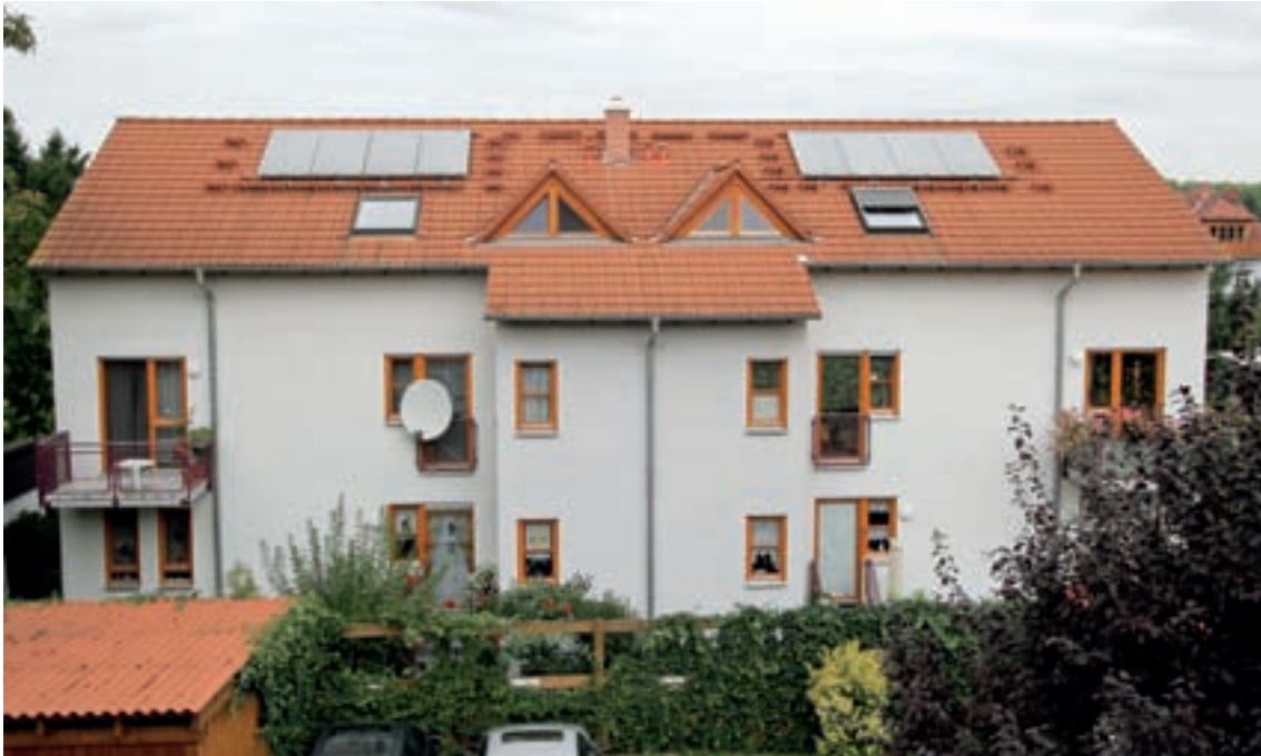
Altrip, Mozartstraße 6, 6 WE, Baujahr 1996. Warmwassererwärmung mit Sonnenkollektoren. Planung Roland Unold. Bauleitung Josef Diehl
