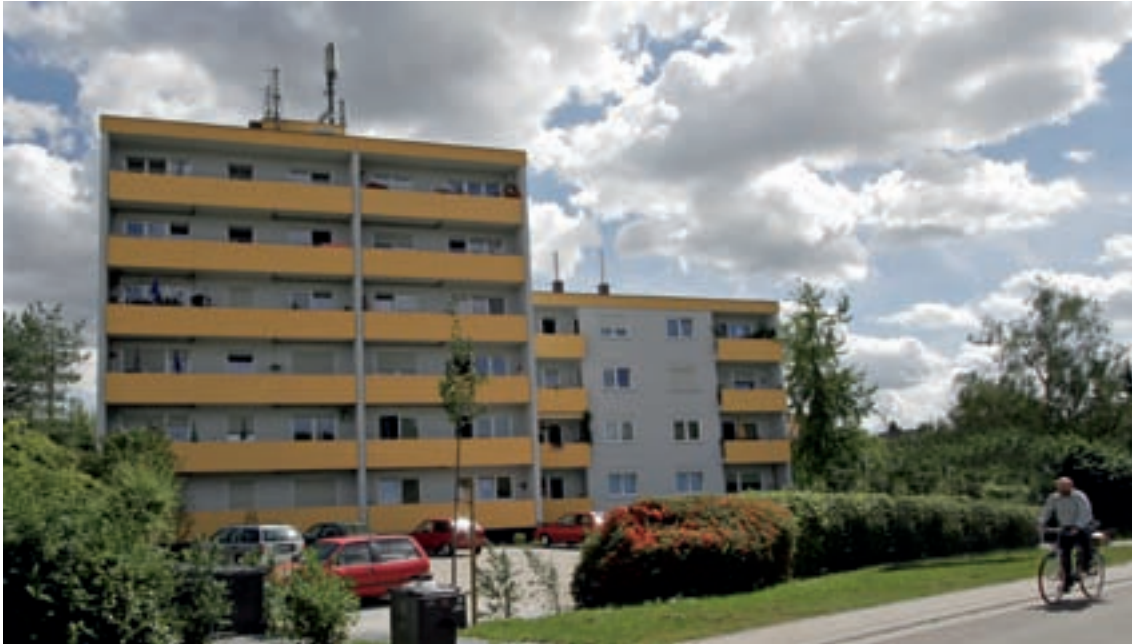
Neuhofen, Rehbachstraße 1/3, 20 WE, Baujahr 1976 Sanierung 2004, Bauleitung Horlacher Architekten
