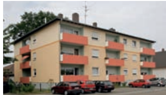
Birkenheide, Sachsenstraße 11 Sanierung 2004
