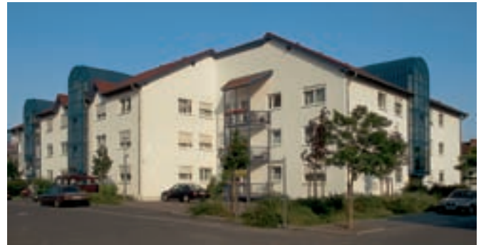
Böhl-Iggelheim, Lilienstrasse 22a/Am Kirchgraben 15/17, 24 WE, Bj. 1992 Planung und Bauleitung Architekt Josef Vogt
