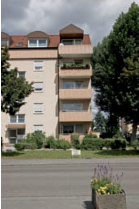
Neuhofen, Raiffeisenstraße 5/7, 16 WE, Baujahr 1973 Flachdach-Aufstockung 1996 mit 4 WE Planung und Bauleitung Architekt Wilfried Schulz
