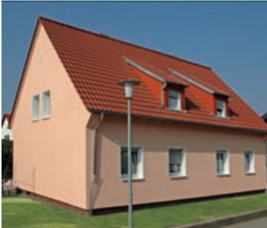
Bobenheim-Roxheim, Richard-Wagner-Straße 42 Vollwärmeschutz, Dachisolierung, Umgestaltung Außenanlage
