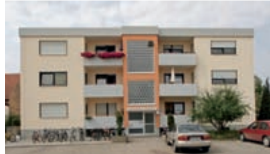
Lambsheim, Heßheimer Straße 5 Sanierung 2004
