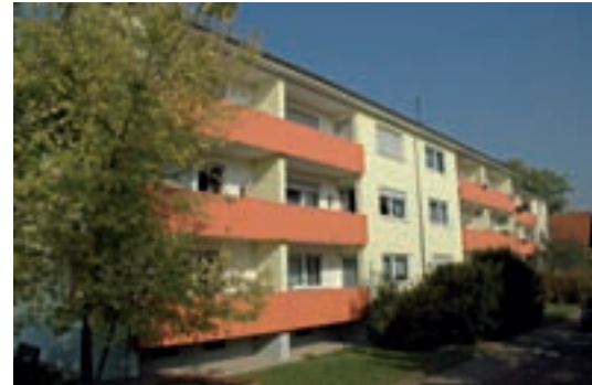
Bobenheim-Roxheim, von-Heyl-Straße 8a-c Sanierung Außenfassade und Neugestaltung des Wohnumfeldes
