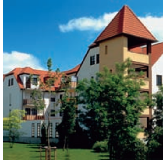
Bobenheim-Roxheim, Limburgstrasse 16-19, 15 WE, Bj. 1987 Planung und Bauleitung Architekt Leo Uhl
