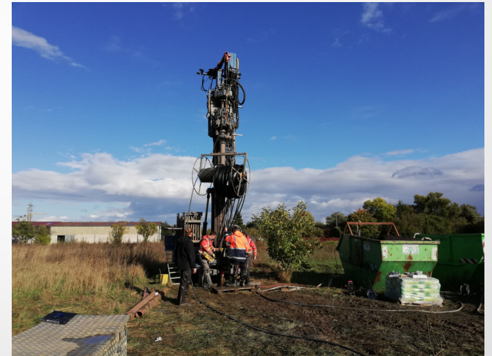
Einbringung der Erdsonde
