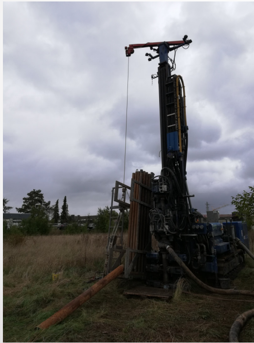
Aufbau Bohrgerät - Bohrbeginn
